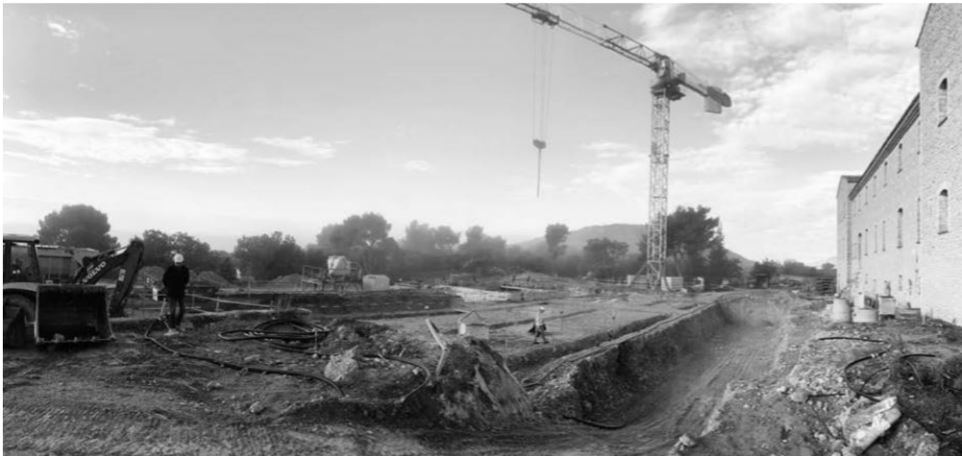
Vue générale du chantier au sud
