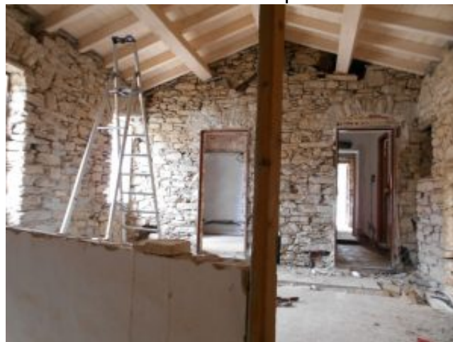
Le bâtiment Saint Jean : après les travaux
