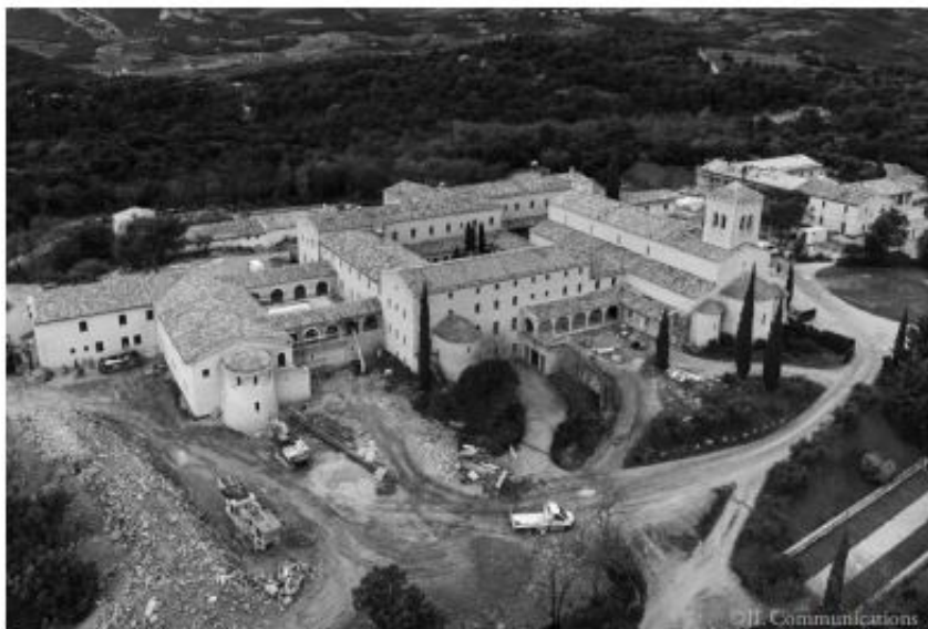
Le neuf se fond dans l'ancien : vue générale des travaux d'extension
